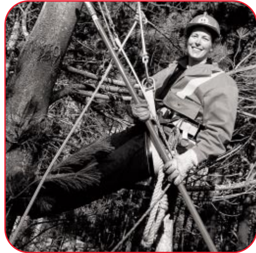
Élagage des branches autour des lignes électriques pour assurer la fiabilité du réseau. Sur la photo, Kim Meeker, agent d'entretien régional, services forestiers.
