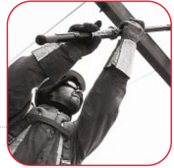
Remplacement d'un poteau de bois à Allanburg
