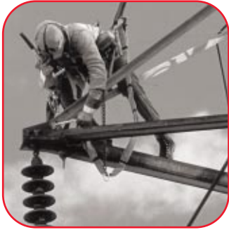
Remplacement prévu des consoles d'une tour de transmission à Mississauga
