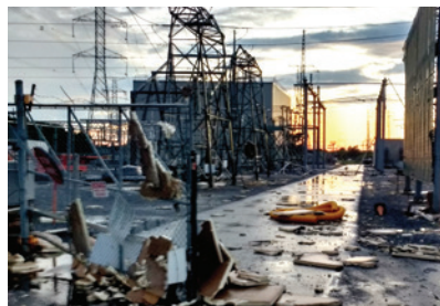
Poste de transport de Merivale, près d'Ottawa, après le passage d'une tornade le 21 septembre 2018.
