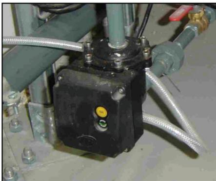
**Figure 14 – Exemple de purgeur à dépression**
